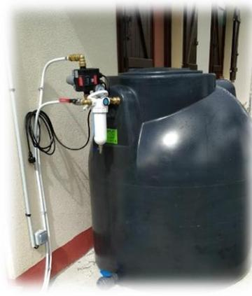
Exemples d'installations de cuves de stockage d'eau potable
