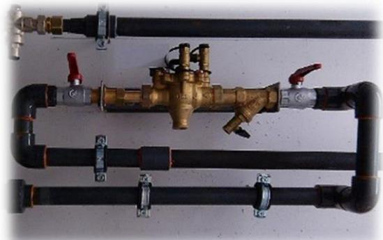
*Exemple d'une installation avec disconnecteur*
