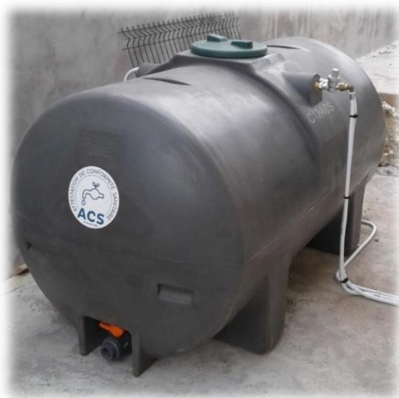
*Exemple d'une cuve de stockage disposant d'une ACS (Attestation de Conformité Sanitaire)*
